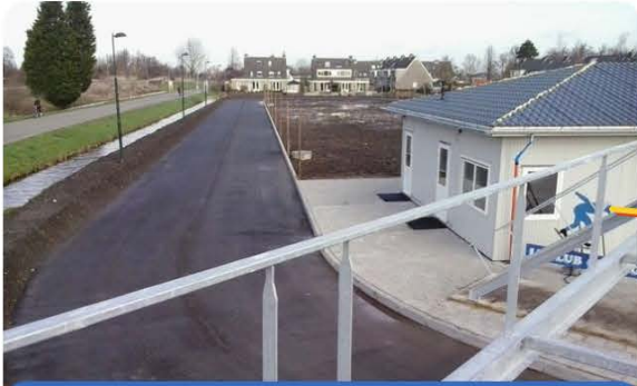
Mei 2014 wordt de asfalt toplaag aangebracht. De baan is af, maar het clubhuis nog niet.
