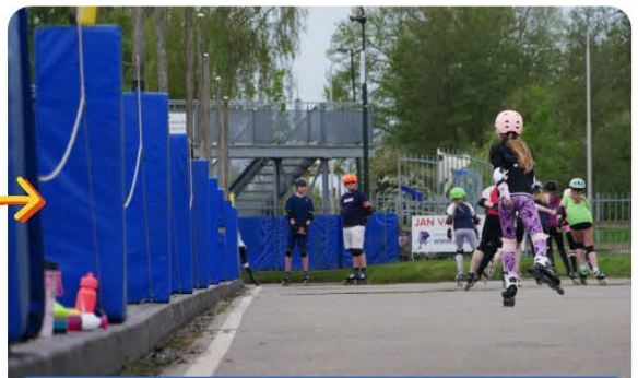
Na veel vergaderingen het besluit: een nieuwe asfalt toplaag en de zuiderbocht moet worden opgehoogd, tot wel 15 centimeter!
